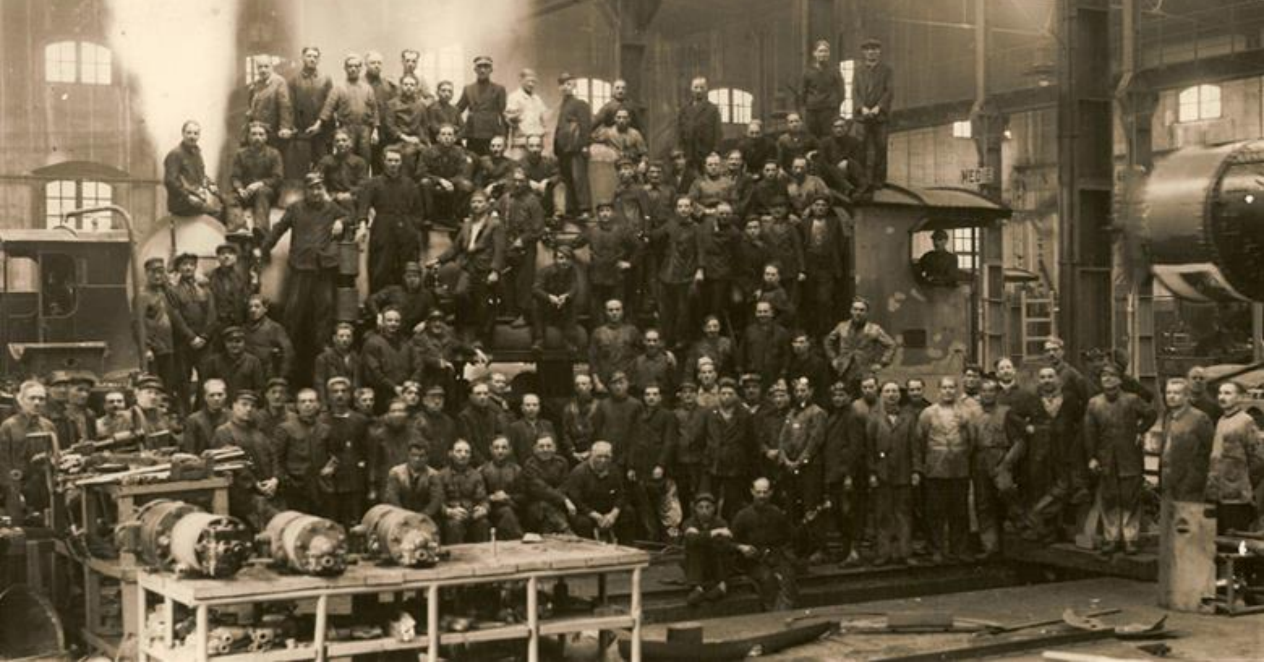
Il complesso siderurgico di Pietrarsa (il più grande polo industriale meccanico d'Italia).
